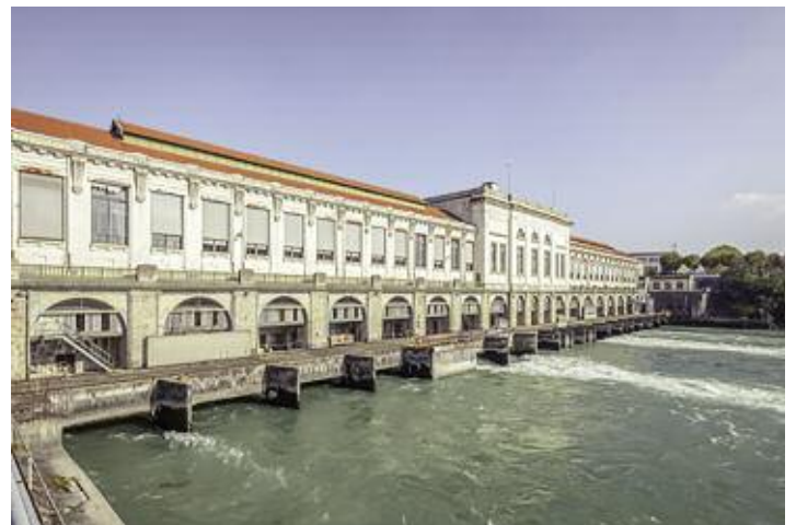
Aujourd'hui. Usine-barrage - Façade sud – Photo Xavier Spertini
