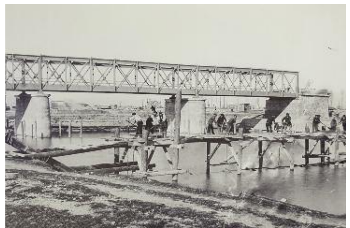
1897. Pose du syphon double de la Rize. Aval du pont de Cusset. Photo La ficelle d'après La construction du canal de Jonage de Varaschin
