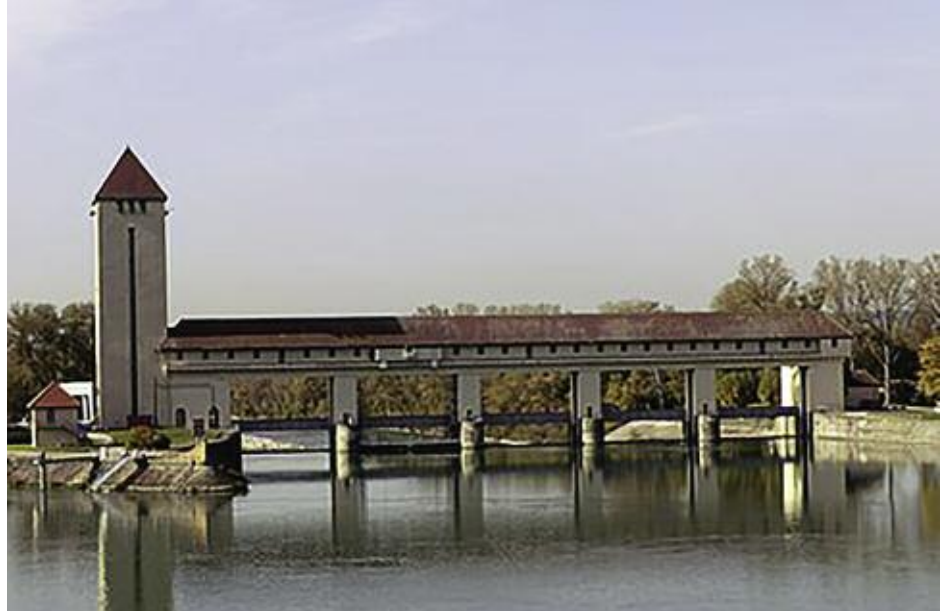
Barrage de Jons - photo Benoît Prieur 1975
