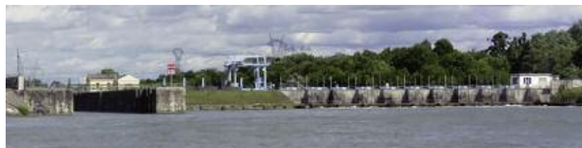
Barrage de Jonage avec écluse. Le barrage de 154 m de long comporte vannes à commande mécanique et vannes à commande hydraulique. Il règle le débit tout en servant de bac de décantation. Il perd son rôle majeur après la construction du barrage de Jons en 1937, mais gère toujours la régulation du niveau d'eau entre Jonage et Cusset et protège des inondations les plaines alentour.
