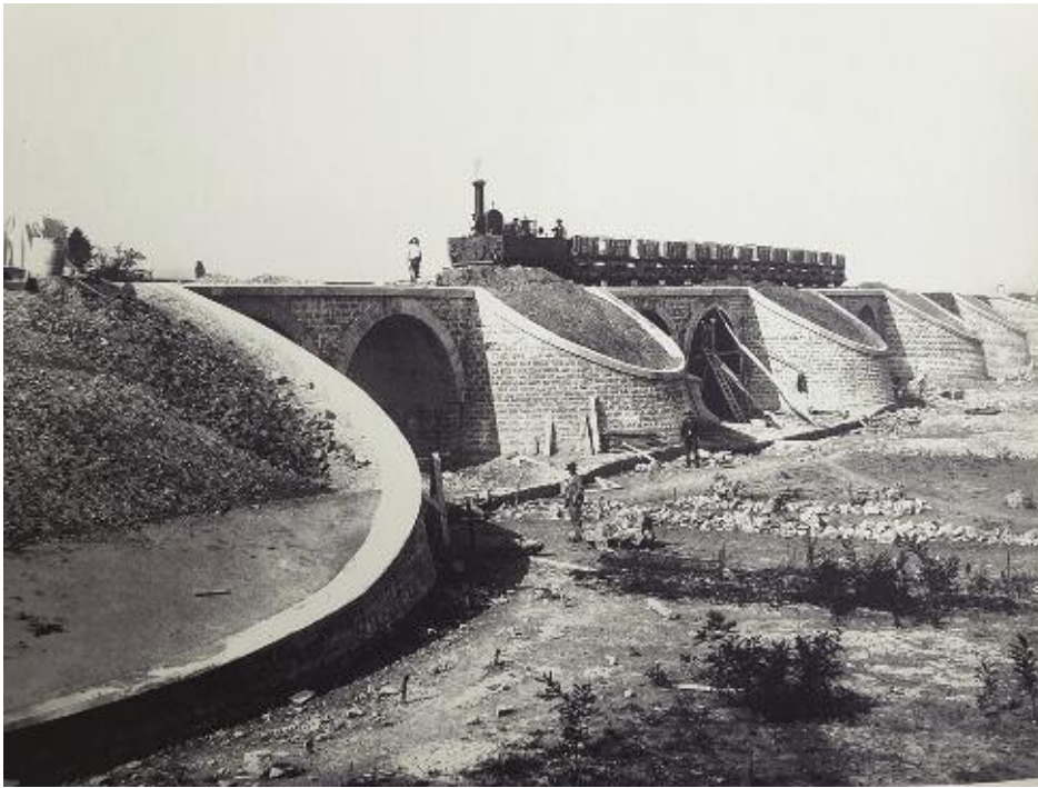
Septembre 1896 – Vue d'ensemble du déversoir à l'aval. Déversoir et réservoir du canal d'aménée sont conçus pour réguler les eaux à l'approche de l'usine-barrage
