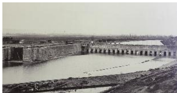
1897 - Ancien mur de garde de Jonage et écluse. Vue à l'aval
